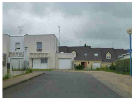
Habitat groupé, locatifs sociaux: rue du Chéran/allée du Limet
